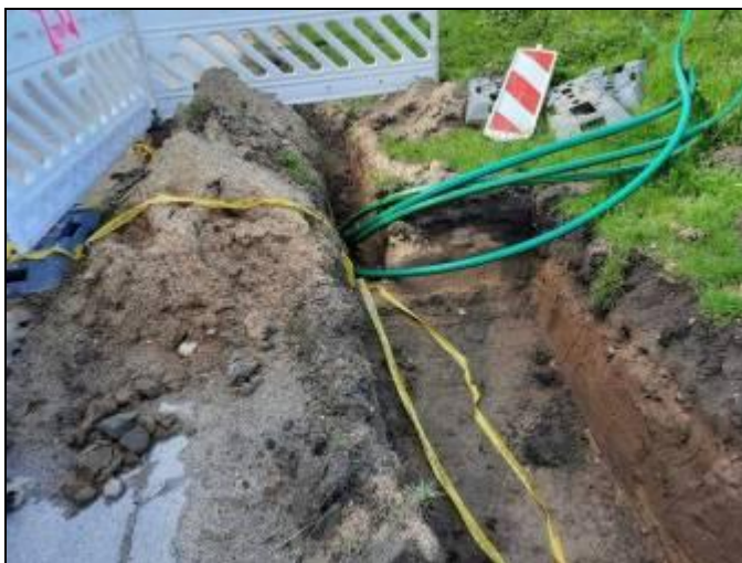
Abbildung 18: Verlegung des Glasfaserkabels im Gemeindegebiet nahe Salzau (Foto: ALSE GmbH, Mai 2021)
