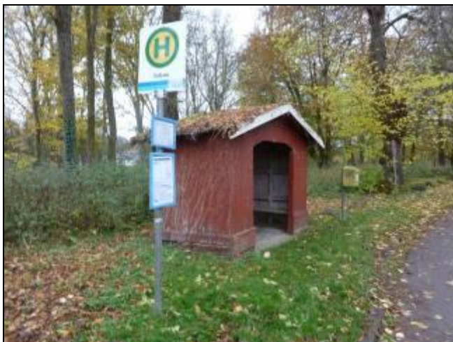
Abbildung 12: Bushaltestelle Salzbau (Foto: ALSE GmbH, Mai 2021)
