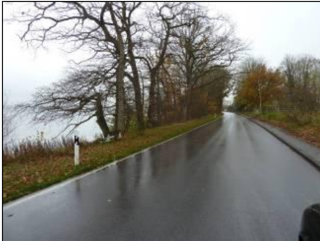
Abbildung 13: Beispiel für teilweise gefährlich schnell befahrene Straßen im Gemeindegebiet, Hauptstraße „Am See“ in Richtung Süden (Foto: ALSE GmbH, Nov. 2021)
